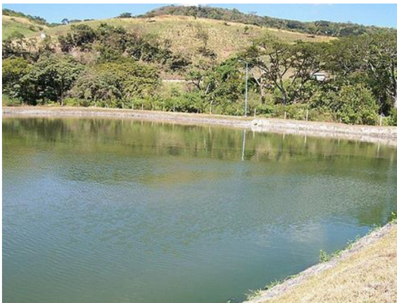
Figura 35. Laguna de maduración Cortesía de Sedapal
