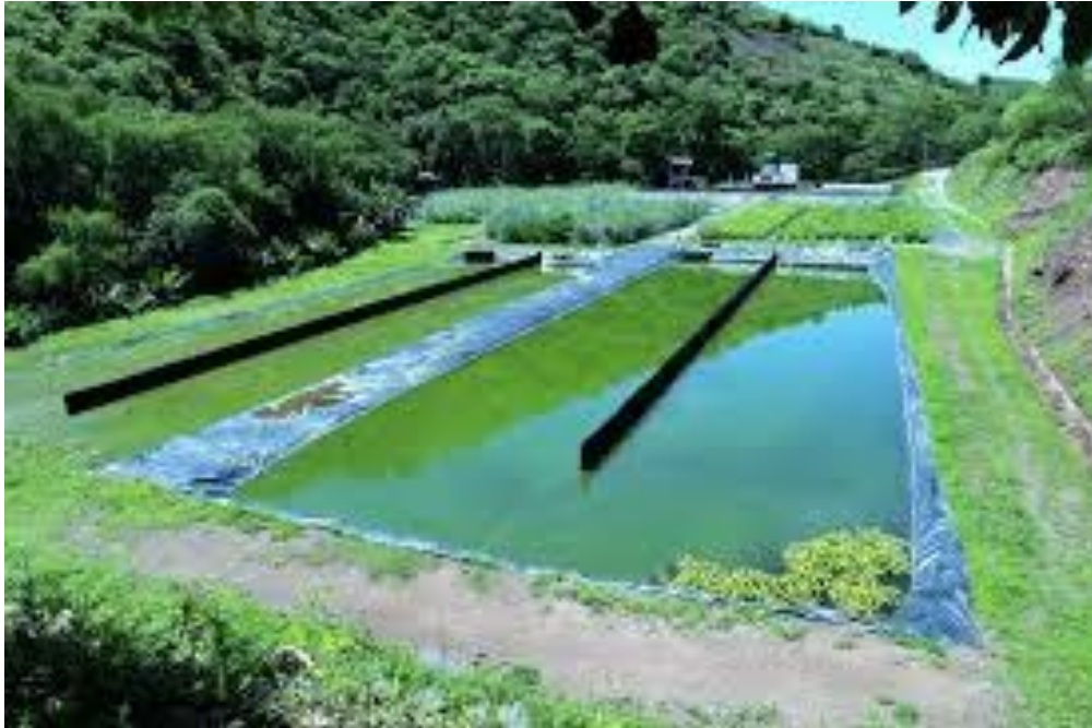
Figura 28. Laguna de maduración
