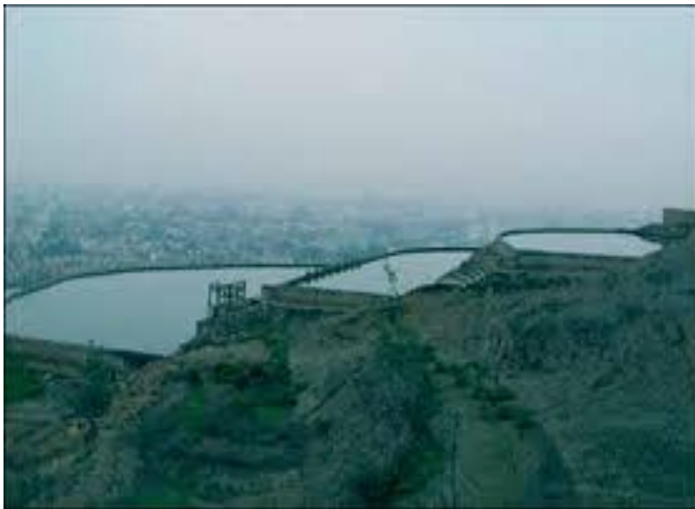
Figura 37. Foto de laguna de maduración terciaria Cortesía de Sedapal
